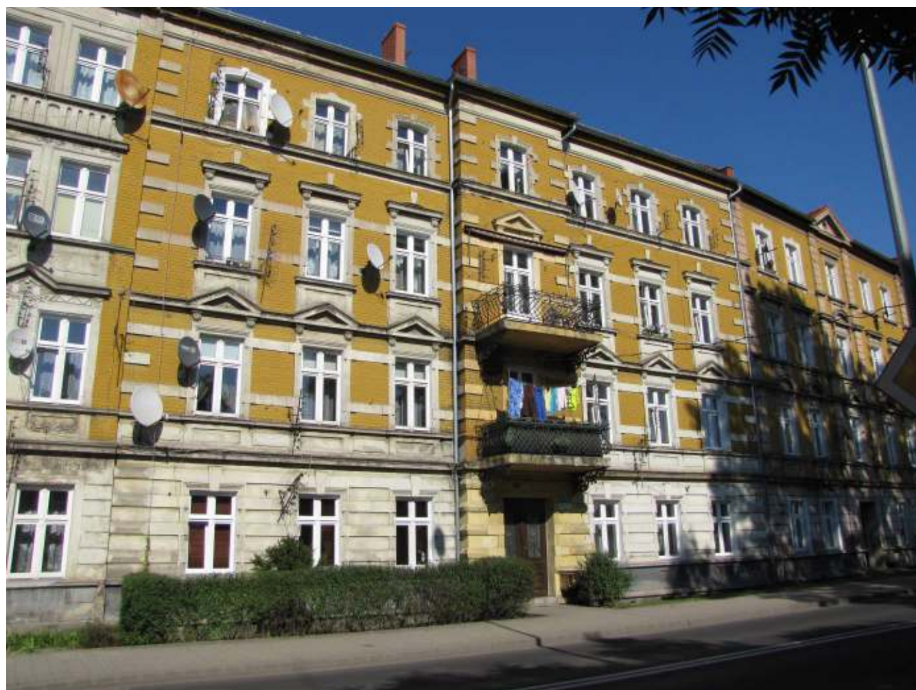
Fot. Elewacja frontowa
